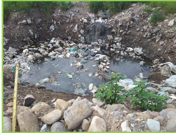
**Imagen No. IV.3.5.3.3.** Afloramiento de lixiviado encontrado en el sitio. Fuente: Sistemas de Ingeniería y Control Ambiental.
