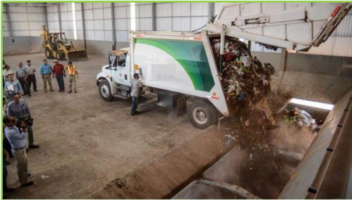
*Imagen No. IV.3.4.1. Descarga de los residuos sólidos en tolva de una estación de transferencia.*
