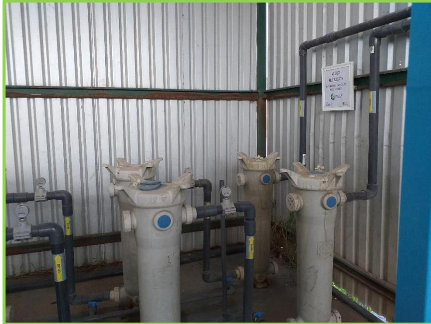
**Imagen No. IV.3.5.2.5.** Filtros retenedores de partículas hasta 5 micras. Fuente: Sistemas de Ingeniería.
