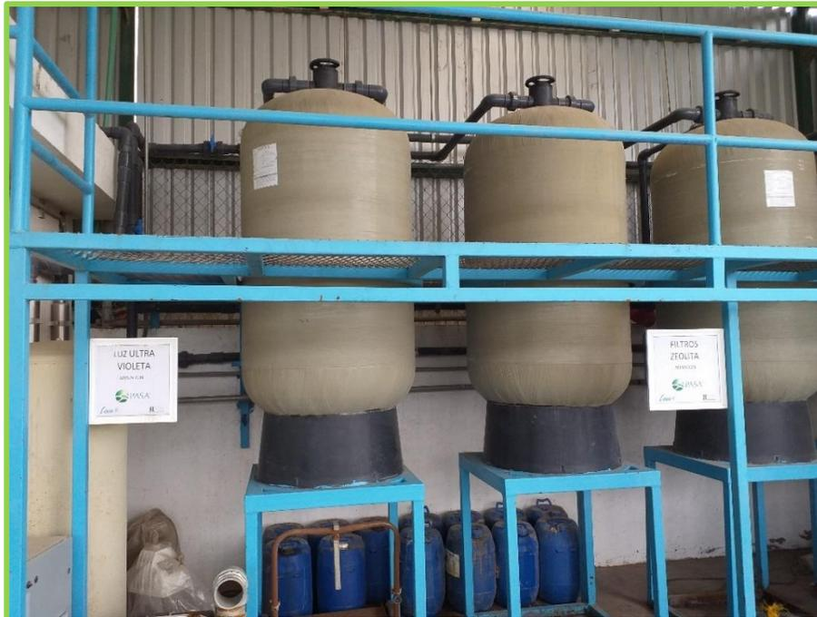
**Imagen No. IV.3.5.2.4.** Zona de filtros de zeolita, son utilizados para retener altas cargas de sedimentos, materia orgánica, clarificar, limpiar los lixiviados. Fuente: Sistemas de Ingeniería y Control Ambiental.
