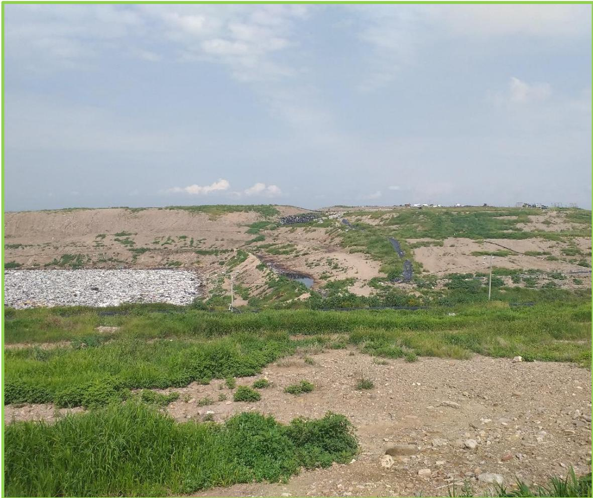
*Imagen No. IV.3.5.3.1. Celda donde se disponían los residuos, actualmente abandonada por el desprendimiento de la geomembrana, ya que el proceso de termofusión fue deficiente: Fuente: Sistemas de Ingeniería y Control Ambiental.*
