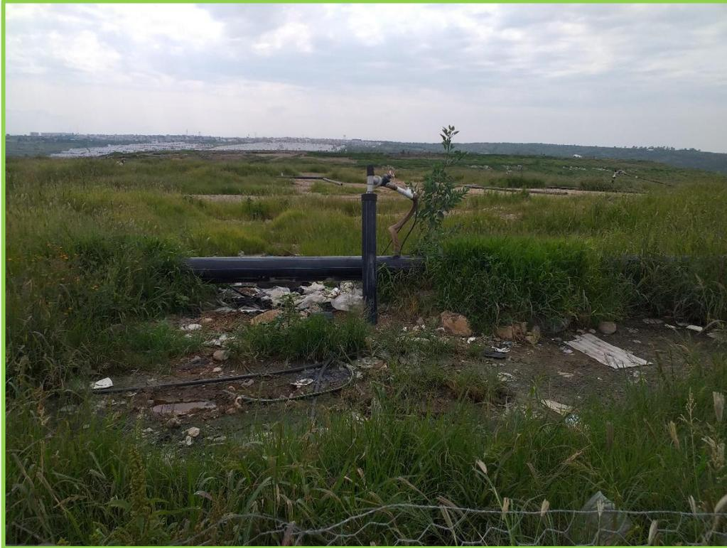
**Imagen No. IV.3.5.3.7.** Conexión del pozo a la red de biogás, nótese la falta de una estructura de resguardo para evitar el desgaste de las piezas por estar a la intemperie.
