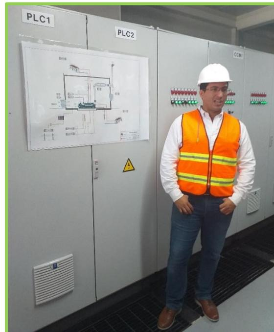
**Imagen No. IV.3.5.2.3.** Tableros donde se ubican los controladores lógicos programables o PLC, en el interior de la planta generadora. Fuente: Sistemas de Ingeniería y Control Ambiental.
